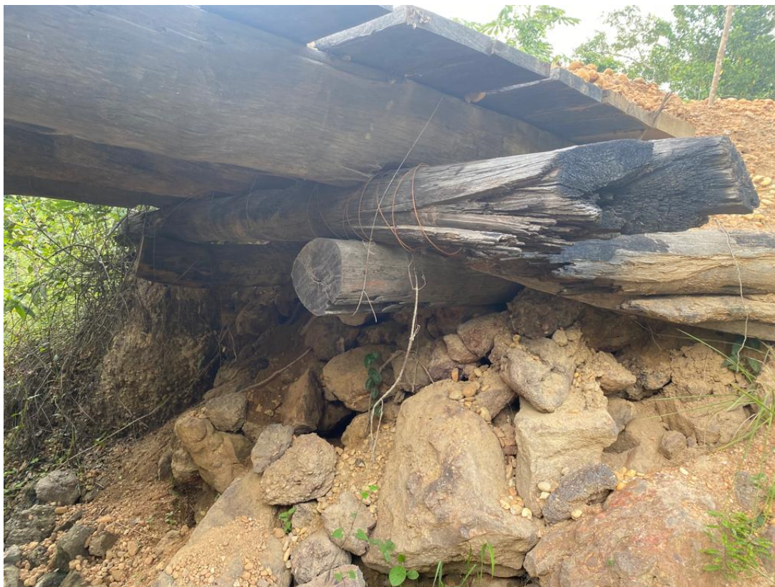
Foto 03: Caimento da encosta.
