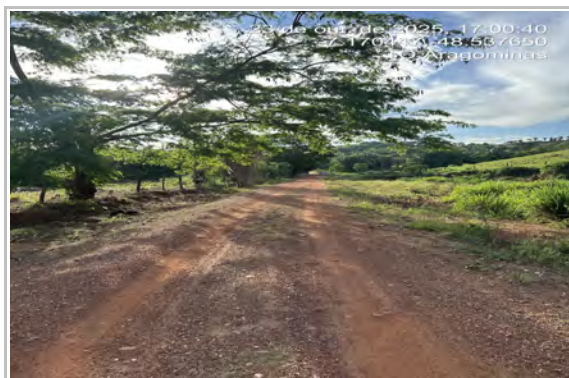
ESTRADA RURAL RUA DO AEROPORTO -7.170447, -48.537650
